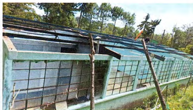
Foto 2: ÁREA DE LA PARTE DE ATRÁS DONDE SE ESTÁ REALIZANDO EL MEJORAMIENTO DE TECHO, MANTENIMIENTO DE COSTANERAS Y MEJORAMIENTO DE CANALETAS CON SU RESPECTIVA CAIDA DE AGUA.
