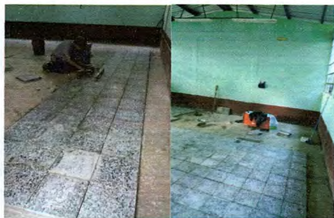
Foto 3: ÁREA DONDE SE ESTÁ REALIZANDO EL MEJORAMIENTO DE PISO E INSTALACIÓN DE TIPO GRANITO.
