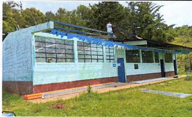
Foto 1: ÁREA FRONTAL DONDE SE ESTÁ REALIZANDO EL MEJORAMIENTO DE TECHO, MANTENIMIENTO DE COSTANERAS Y MEJORAMIENTO DE CANALETAS CON SU RESPECTIVA CAIDA DE AGUA.
